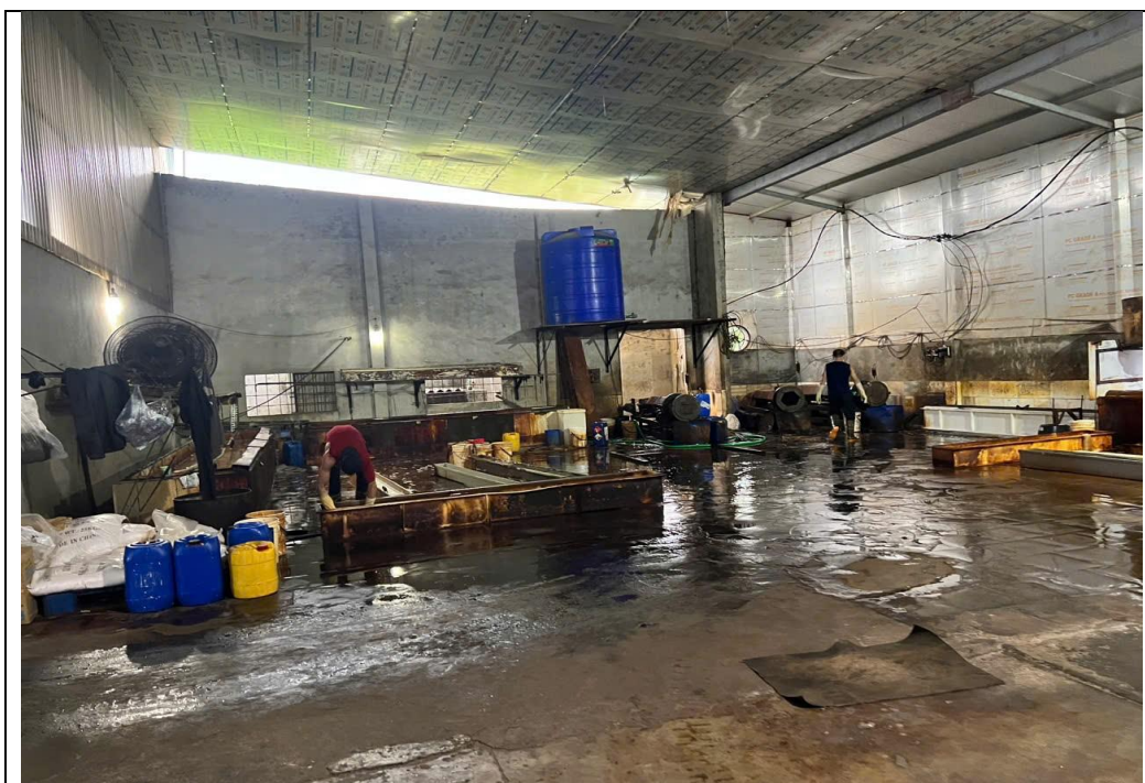
Hệ thống bể mạ Điện phân
